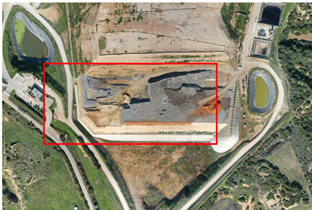
Figura 3.5: Foto aerea dell'area, in rosso il modulo 4
