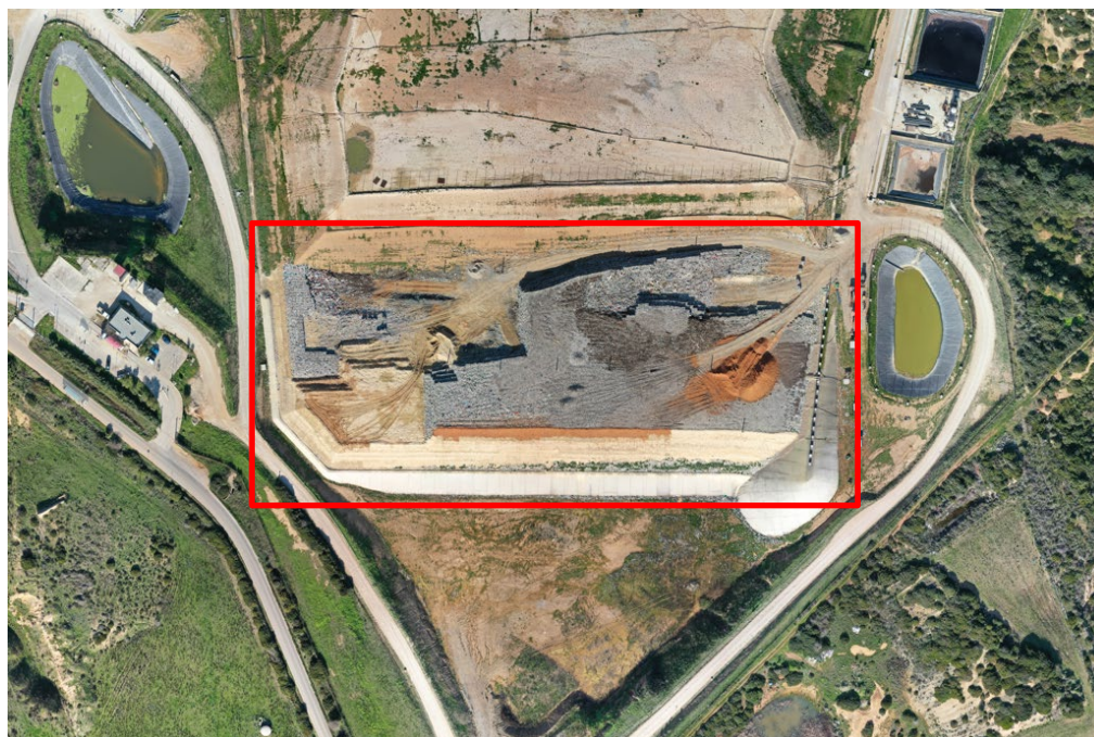
Figura 4.2/D: Foto aerea dell'area, in rosso il modulo 4
