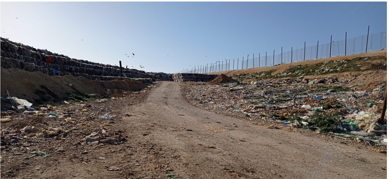
Foto 5. Vista del modulo 4 (da est – punto di presa n.3) – 23.02.2022
