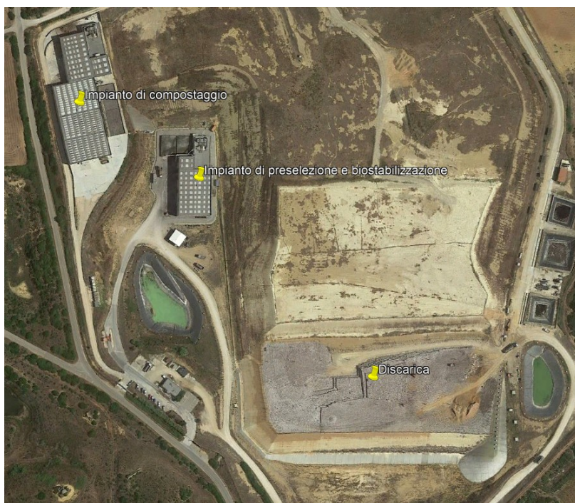
Figura 1. Foto aerea del Sito di smaltimento con evidenziati i tre impianti – Fonte Google Maps
