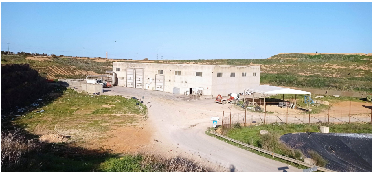
Foto 7. Vista dell'impianto di pre-selezione e, sullo sfondo, i moduli 8 e 9 della discarica (punto di presa n.5) – 23.02.2022
