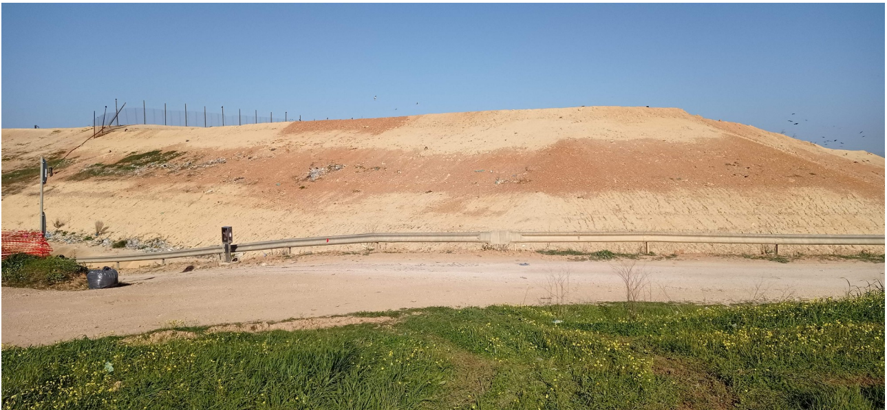
Foto 6. Vista del modulo 4 (da sud – punto n.4) – 23.02.2022
