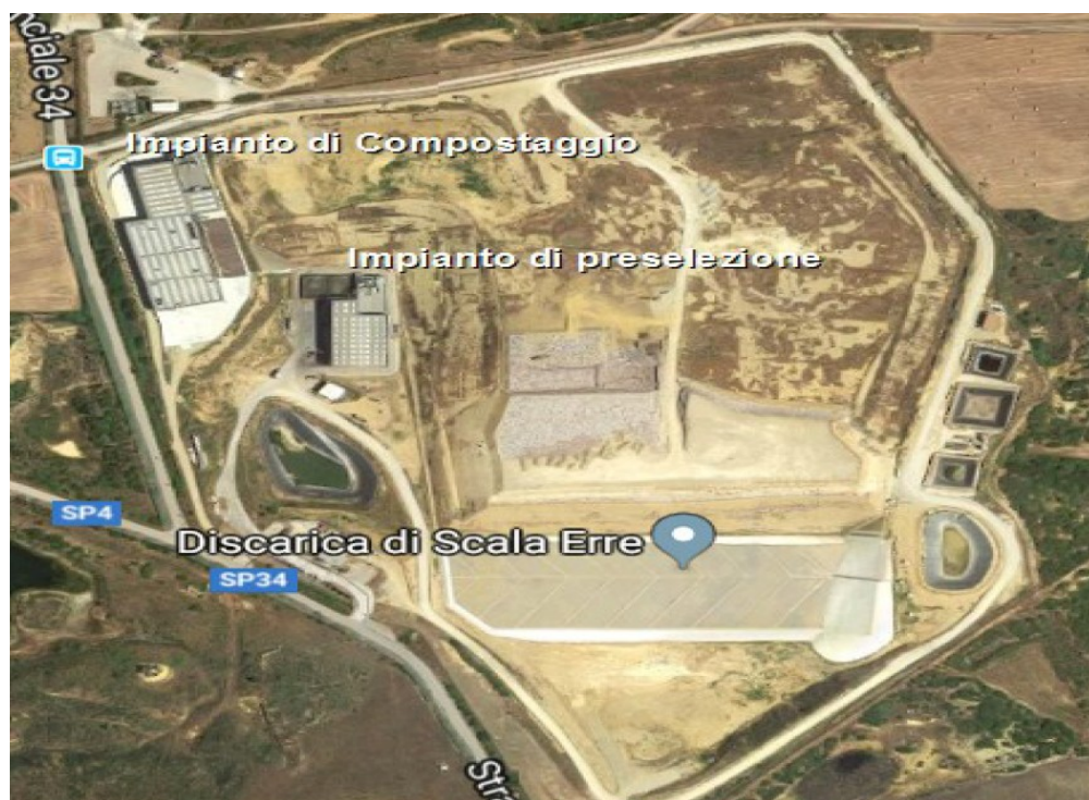
Figura 1 - Vista aerea del Sito di smaltimento con evidenziati i tre impianti – Fonte Google Maps
