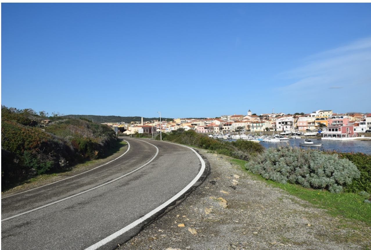
Foto 4. Dello stato attuale
