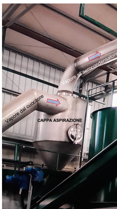
Figura n. 12 – immagine di dettaglio della cappa di aspirazione delle fumare dal cuocitore.
