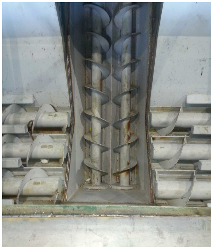
Figura 29: dettaglio delle coclee estrattrici poste all'interno della vasca di scarico dei SOA in ingresso all'impianto.
