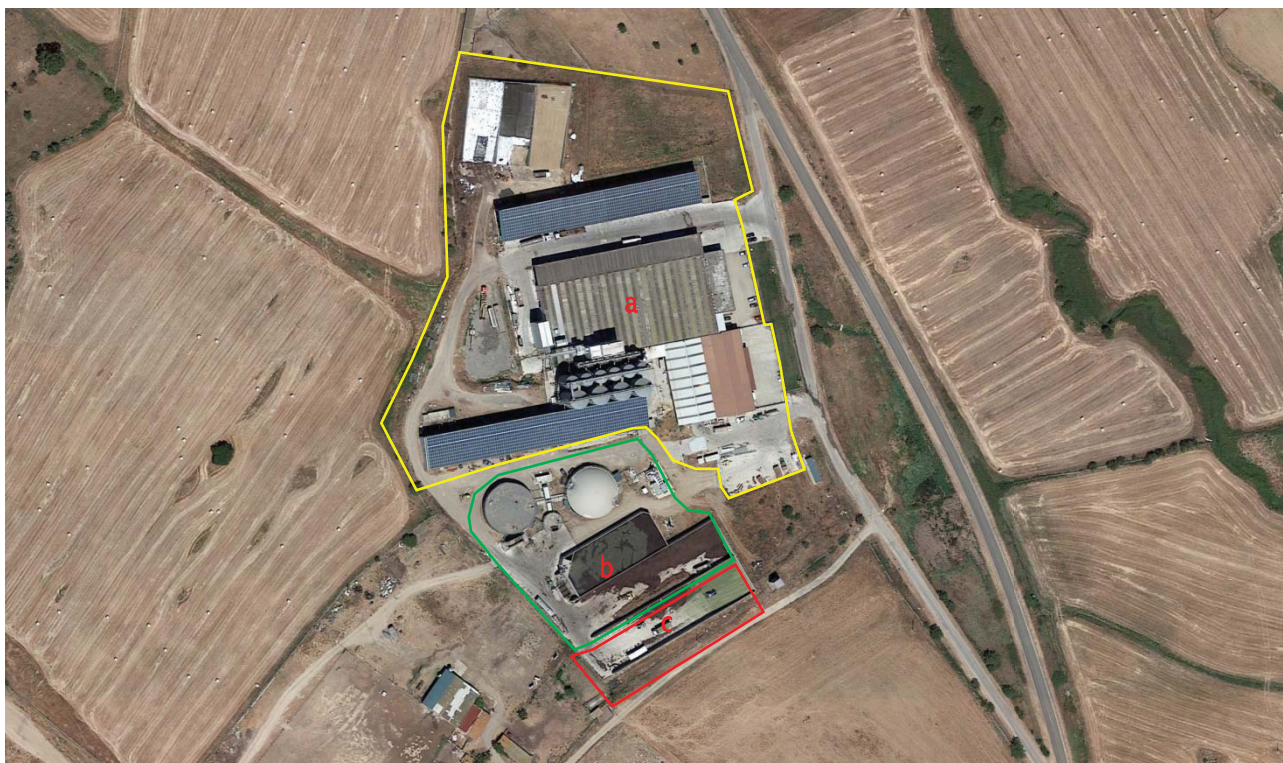
Foto 1: ortofoto con indicazione delle aree operative dell’agglomerato produttivo ove si inserisce la proposta progettuale in valutazione.
