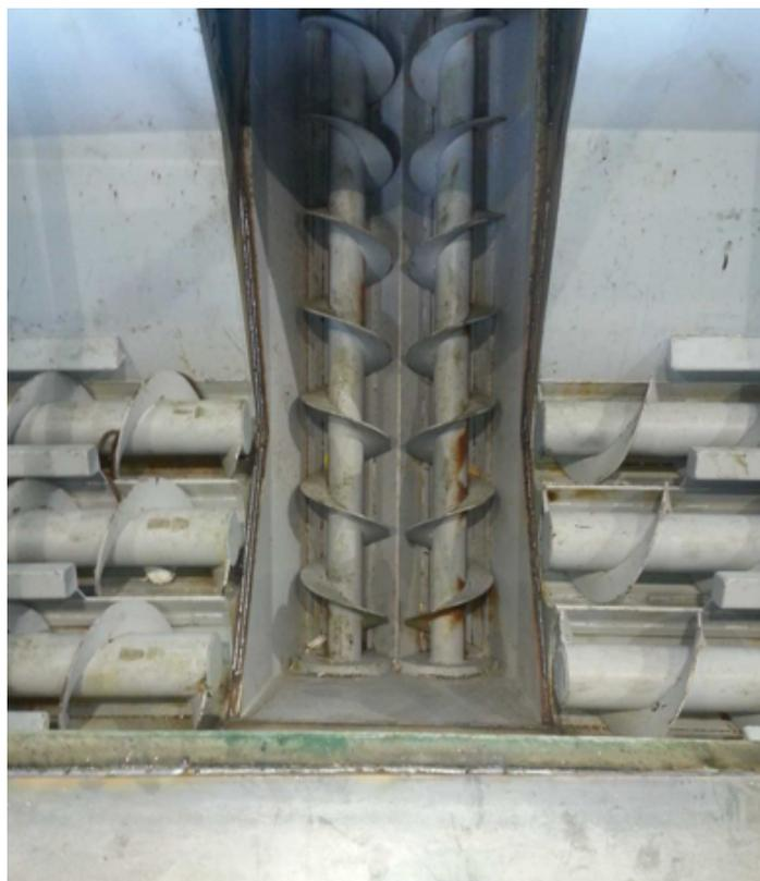
**Figura 30:** dettaglio delle coclee estrattrici poste all'interno della vasca di scarico dei SOA in ingresso all'impianto.
