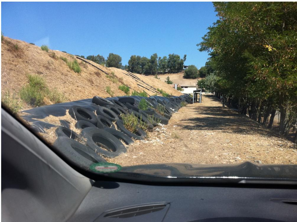
Si nota l'argine perimetrale di delimitazione della discarica, rivestito con guaina in HDPE su cui sono appoggiati i pneumatici con funzione di protezione. Su questa base è stato impostato l'intervento progettuale di realizzazione della canale esterna di raccolta delle acque meteoriche di ruscellamento, secondo lo schema grafico di seguito riportato.
