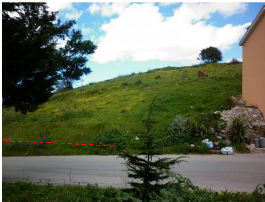
Fig. 19 - Ripresa del versante pendente a Ovest da ridosso di via La Malfa, In rosso la traccia del taglio stradale nell'ammasso roccioso
