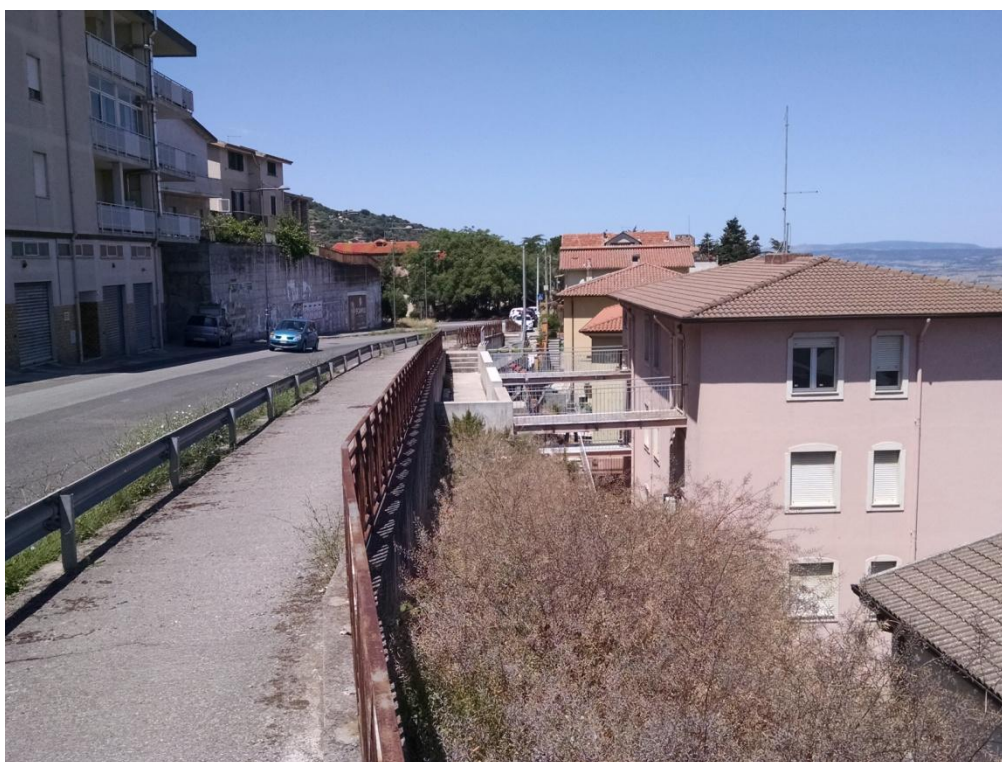
Fig. 38 - Via Punta Idda-Via Roma. Il versante Sud opposto a quello della lottizzazione in progetto, decisamente più acclive, è interessato da viabilità con muri di sostegno sia di controripa che sul lato sottoscarpa dove sono presenti abitazioni sottostanti e travi orizzontali contropinta.
