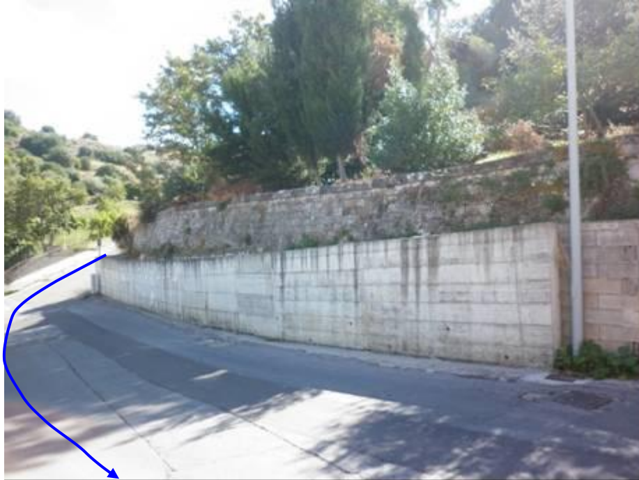
Fig. 30 – Esempio di sottomurazione (doppia in conci in pietra la più antica e in setti di cemento armato la più recente). Prosecuzione di Via La Malfa sul bordo NW dell'Unità fisiografica (ripresa da NW; sullo sfondo Via M. Mela). La freccia segue l'eventuale asse di deflusso superficiale
